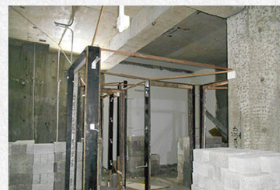
安裝門框工程 — 2017年3月
