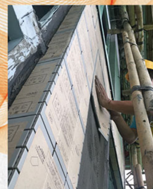
外牆磁磚鋪設 — 2017年5月
