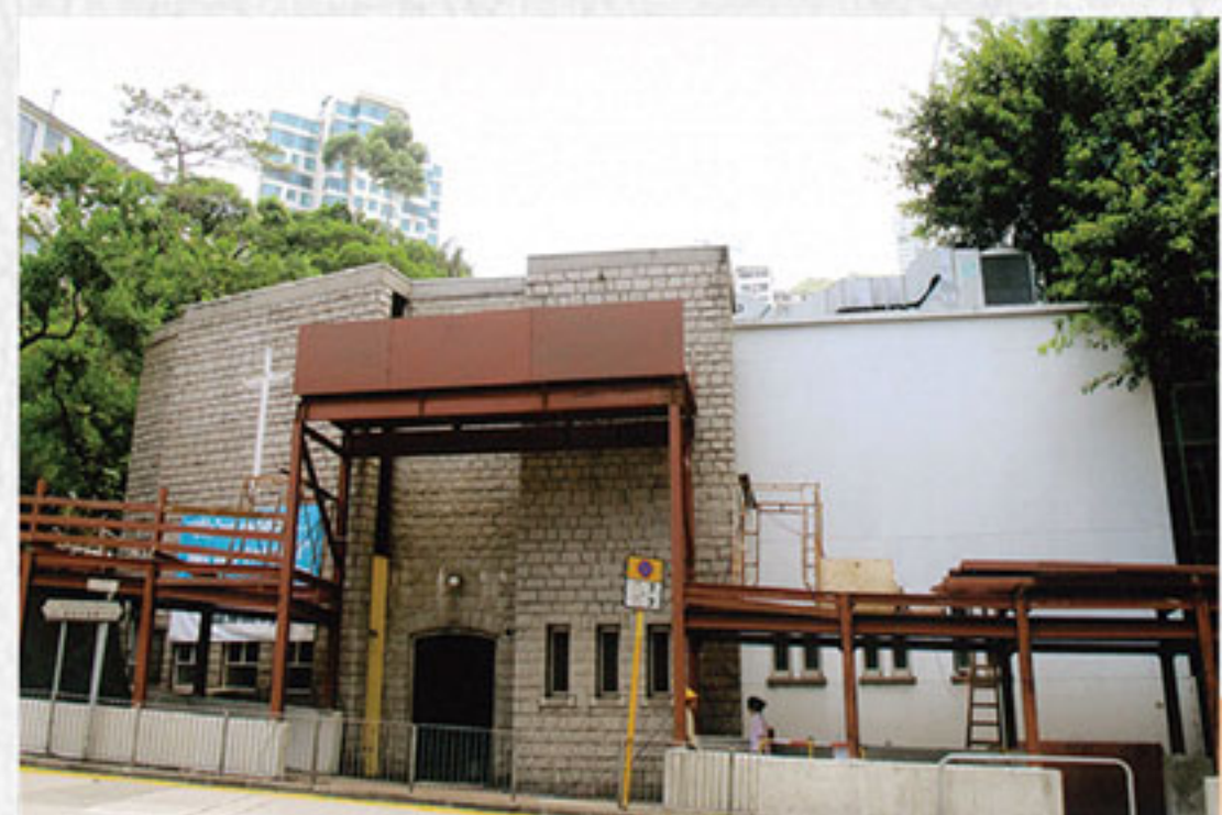
進行地盤圍板工程 — 2014年9月
