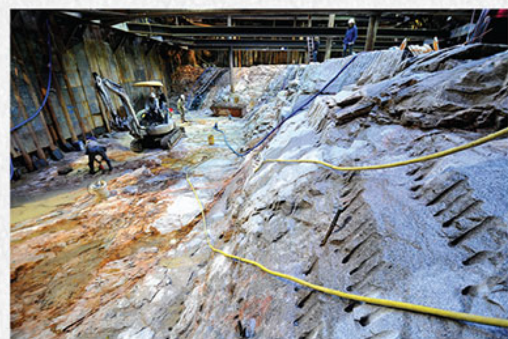
新廈建造於這些堅固的磐石上
